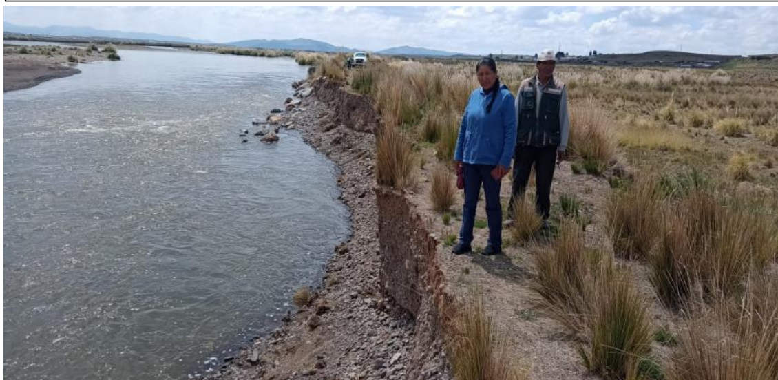
FIGURA N°02: TRAMO CRÍTICO EN EL RÍO CABANILLAS MARGEN DERECHA, DONDE SE OBSERVA EL ENROCADO COLAPSADO
